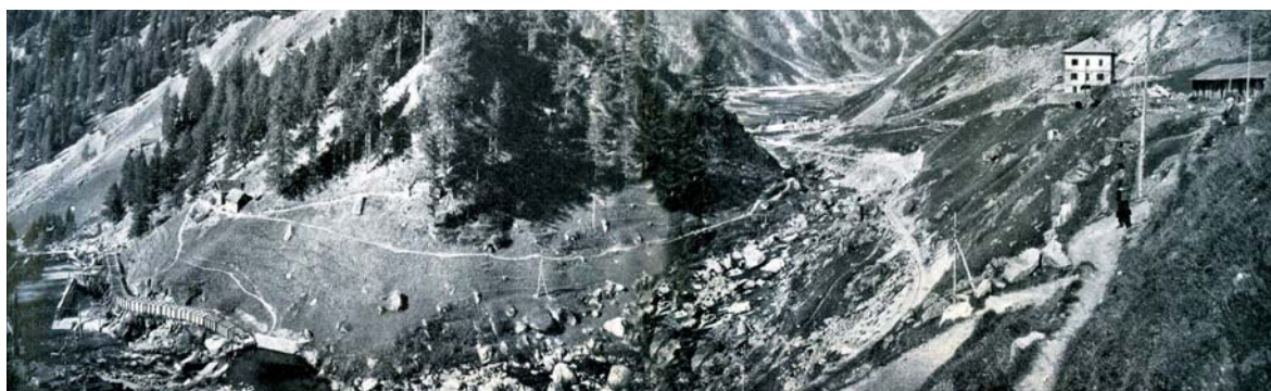
Valle Antrona Alpe Cheggio, lavori di costruzione della diga Alpe Cavalli
