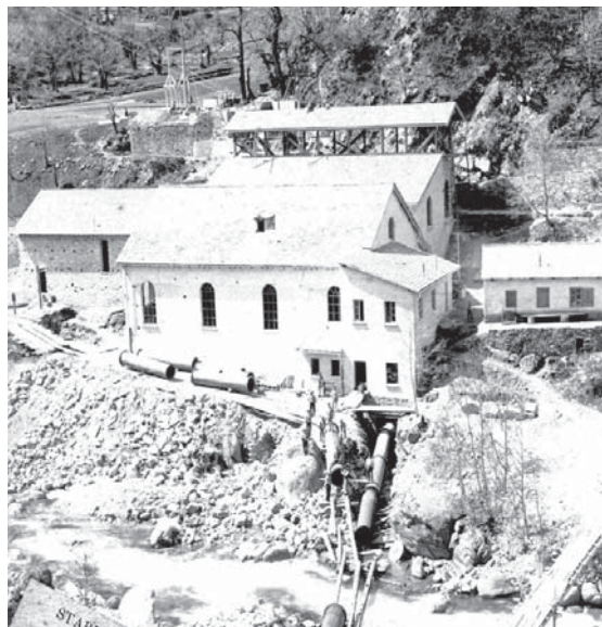
fasi di ultimazione dello stabilimento
